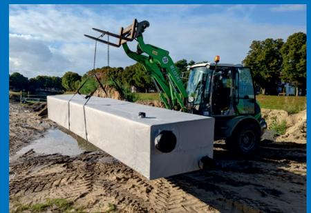
Die HeitkerBloc 400 Werksmodule sind die unkomplizierteste und komfortabelste Möglichkeit der dezentralen Regenwasserrückhaltung und -Speicherung.
