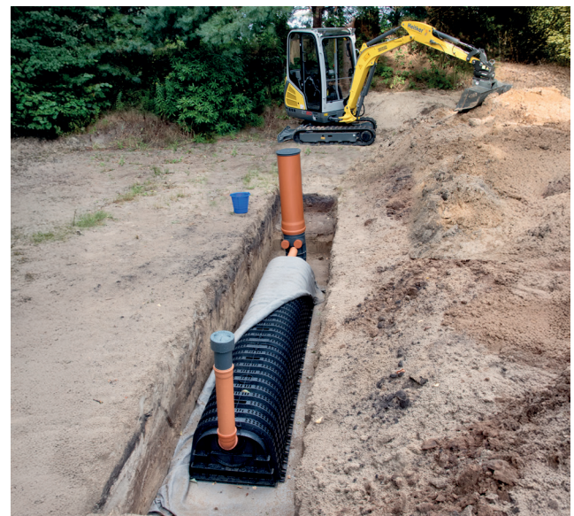
Die Verfüllung erfolgt mit Sand
