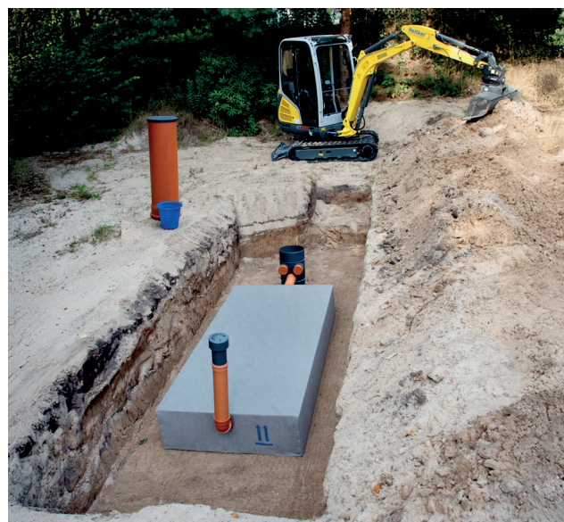
Die Verfüllung erfolgt mit Sand
