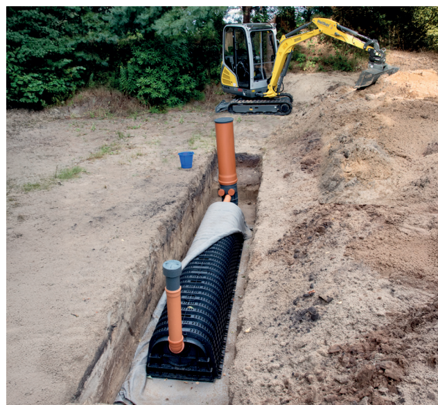
Die Verfüllung erfolgt mit Sand
